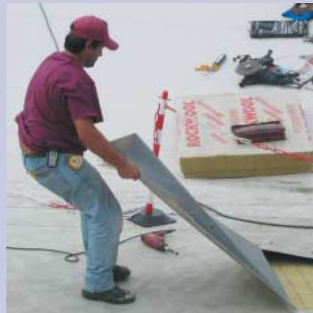
Die ausgedienten Dachbahnen werden in zirka einen Meter breite Streifen geschnitten...
