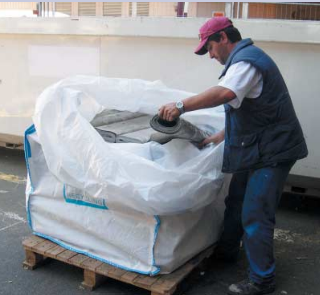
Möglichst eng gerollt werden die alten Bahnen in die Big Bags gefüllt
